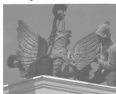
Figura 13 - Colocação da Fênix - MIS
