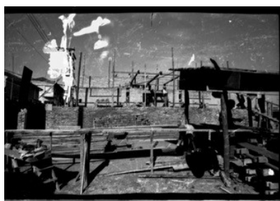
Figura 9 - Início das obras – Fonte MIS
