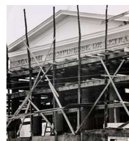
Figura 10 - Obras - Fonte MIS.
